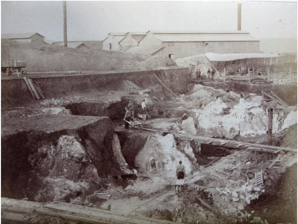
Vue des carrières et de l'usine d'extraction des phosphates de Beauval, fin 19e siècle.
