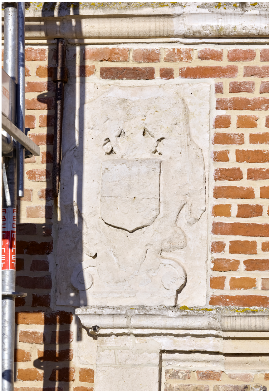
Détail de l'armoire de gauche, porte principale.
