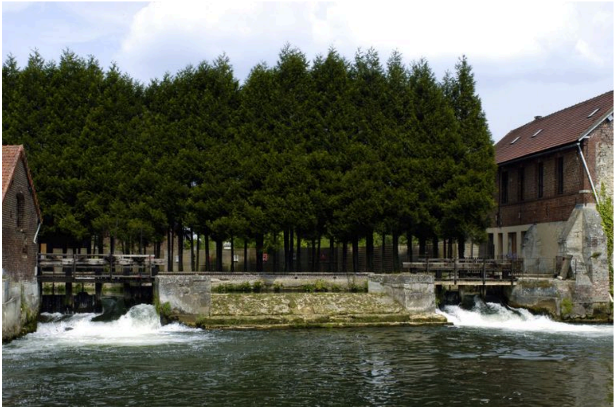
Le déversoir et les vannes de décharge.
