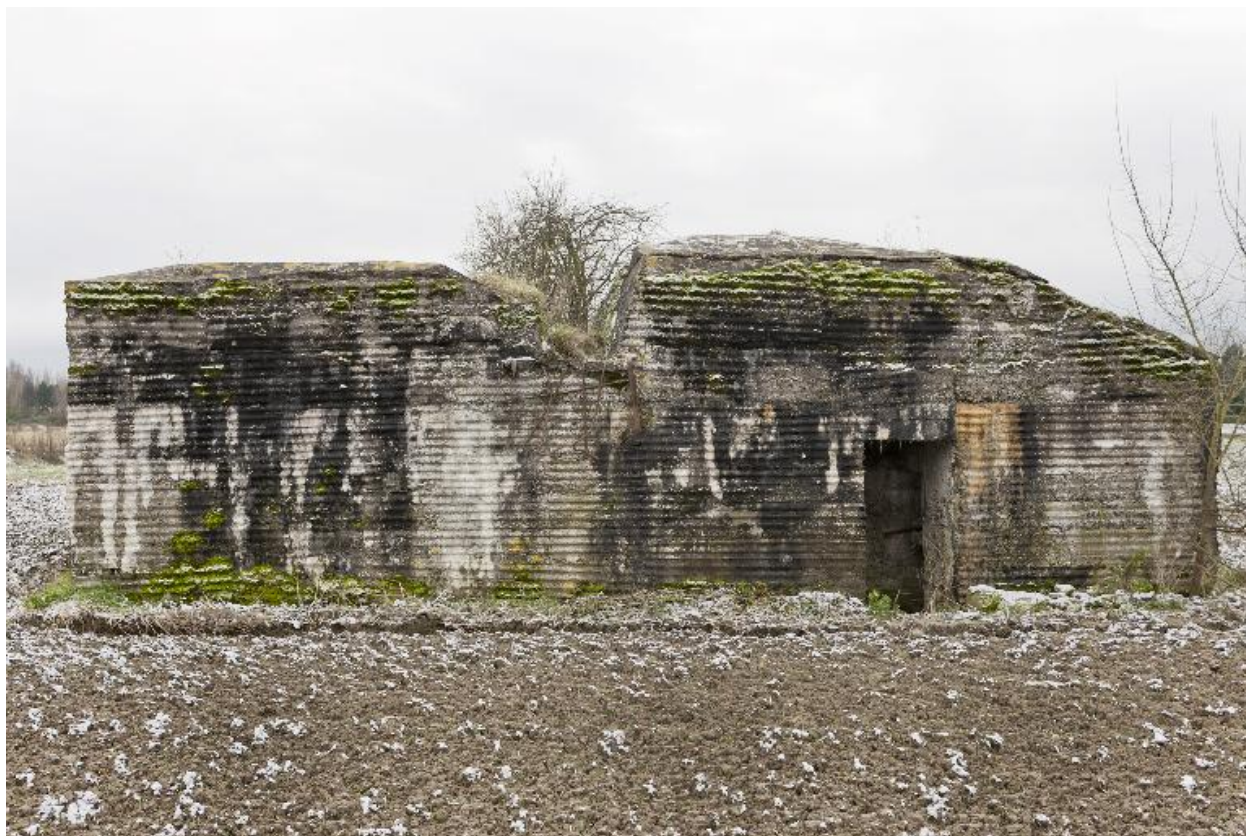
Entrée sur l'élévation nord-est.
