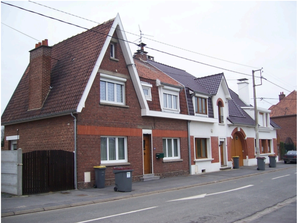
Maisons reconstruites, 55 et 59 rue des Soeurs-Liesse.
