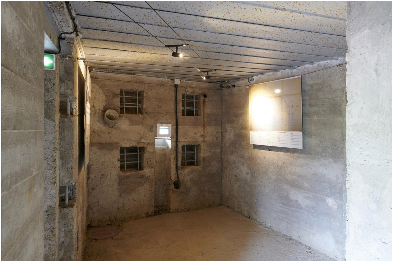
Vue intérieure du local des mitrailleurs. Chambre de tir mitrailleuse.
