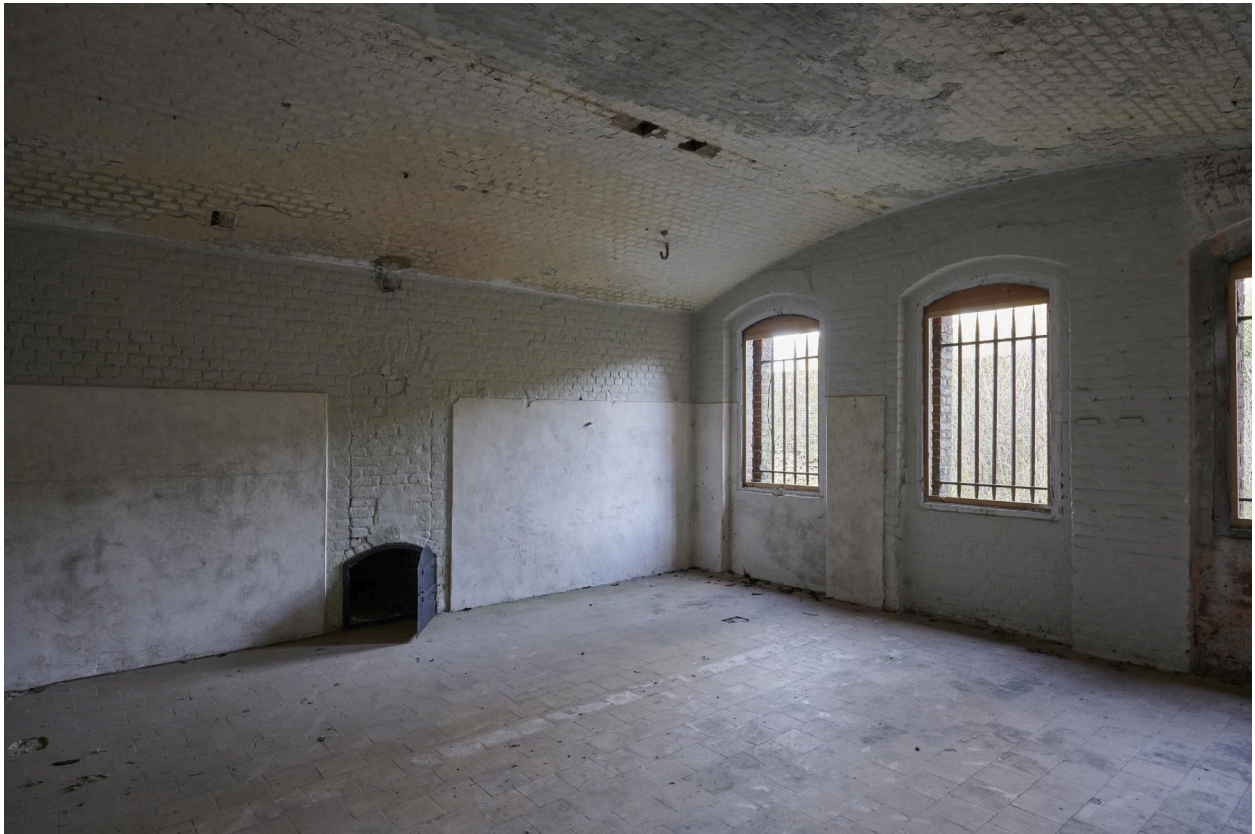
Sous-sol de caserne de gorge. Ancienne tisannerie.
