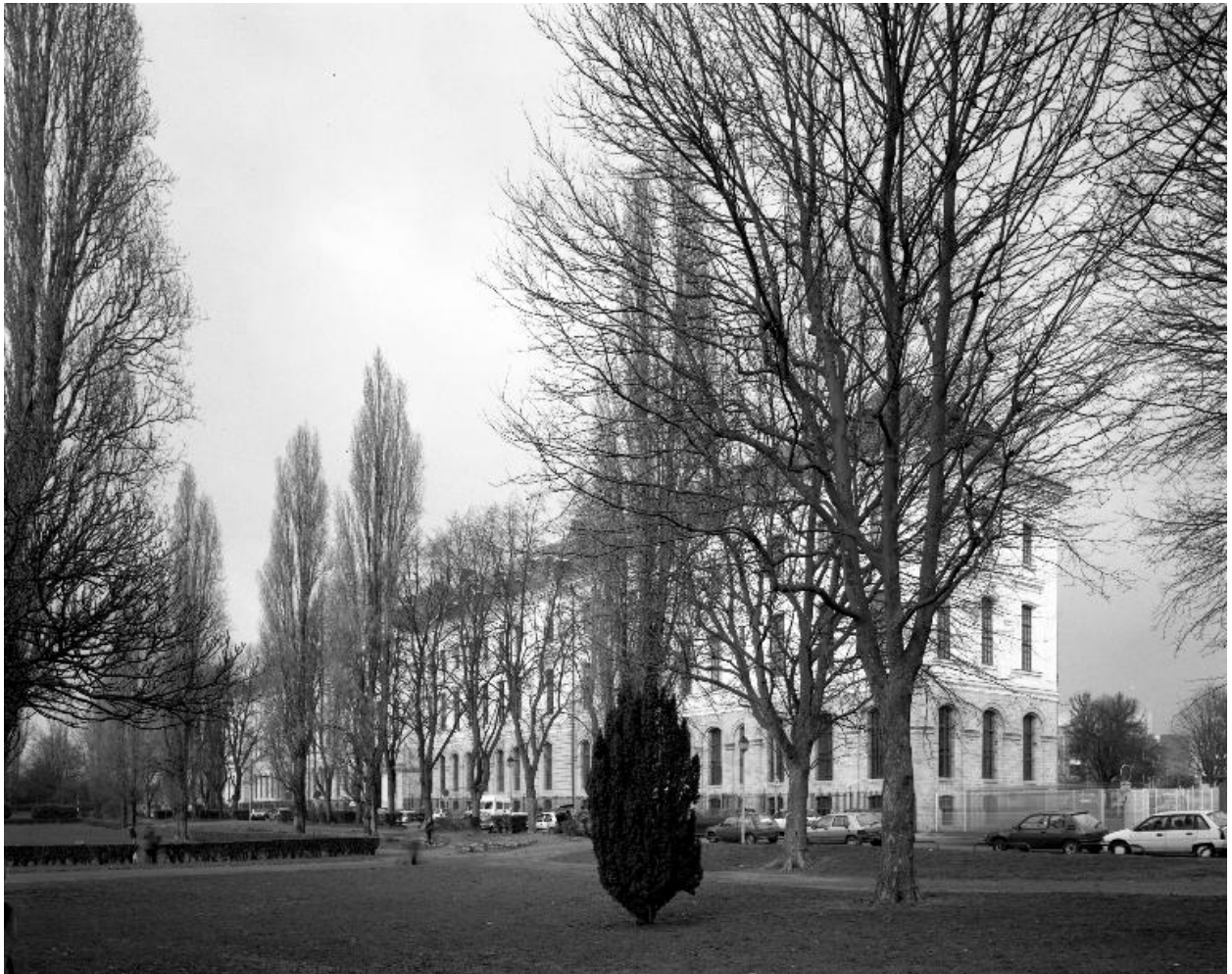
Bâtiment principal, élévation antérieure donnant sur l'avenue du Peuple-Belge, vue générale prise de trois-quarts droit.
