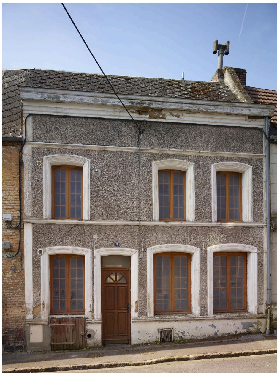
Maison, 5 rue des Lombards : façade entièrement enduite en nid d'abeille.
