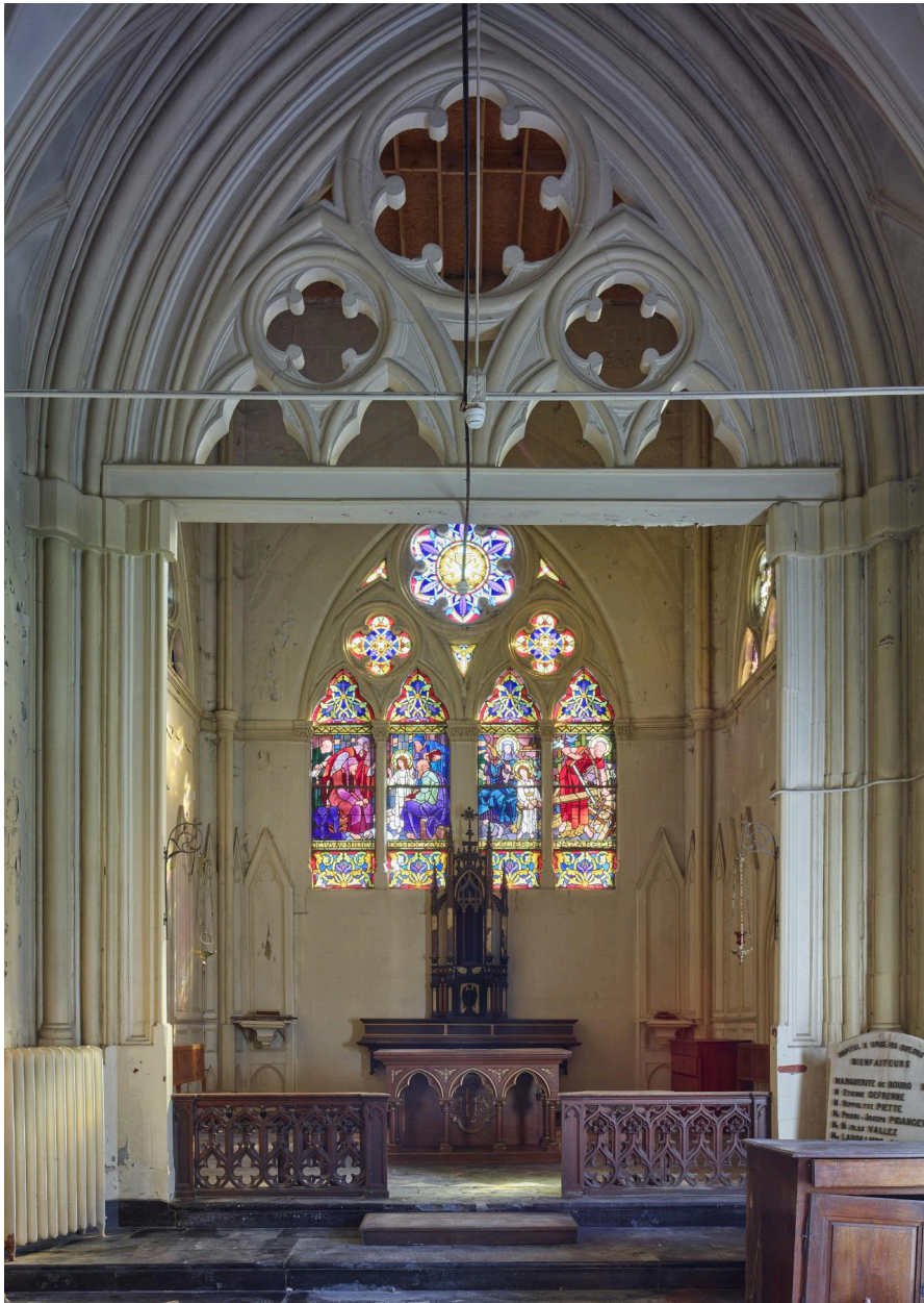
Vue générale du chœur depuis la nef.
