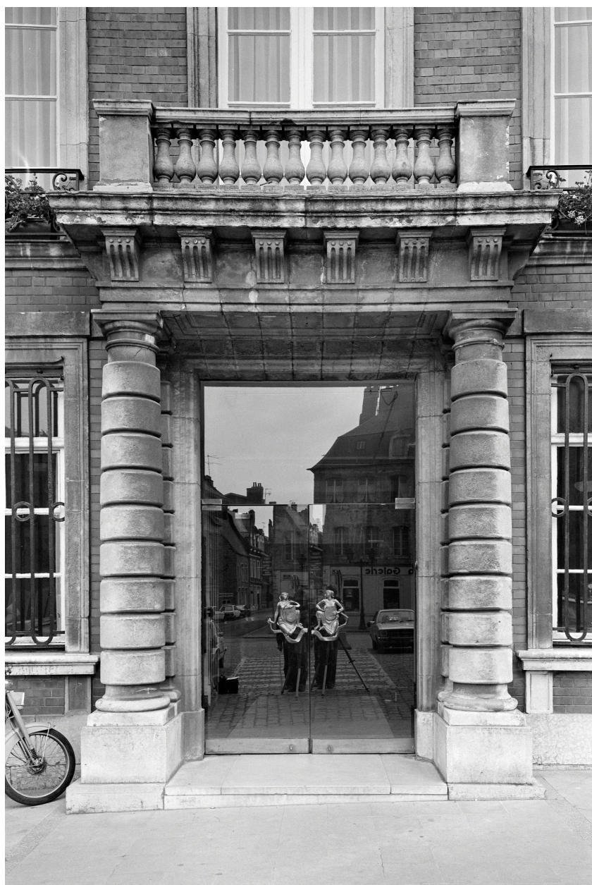
Porte d'entrée principale : détail.
