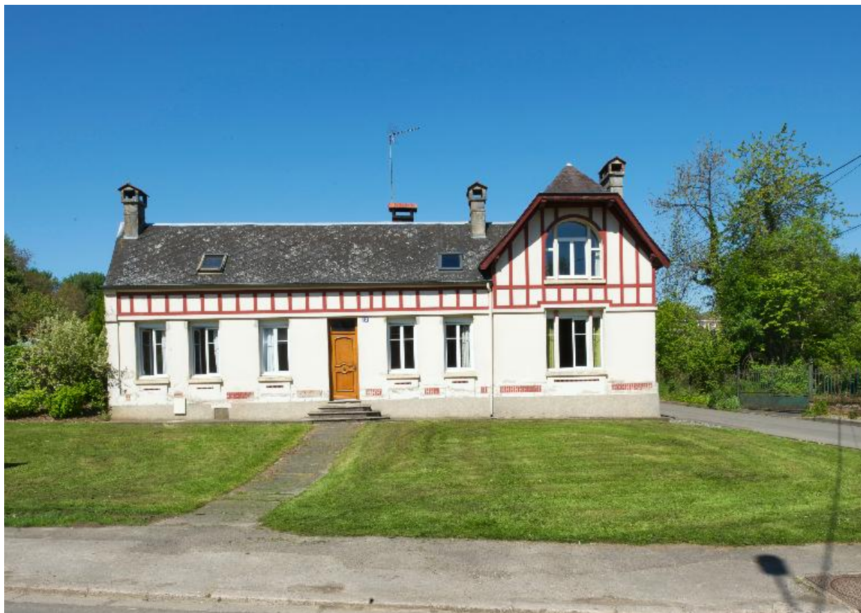
Vue d'ensemble de face.
