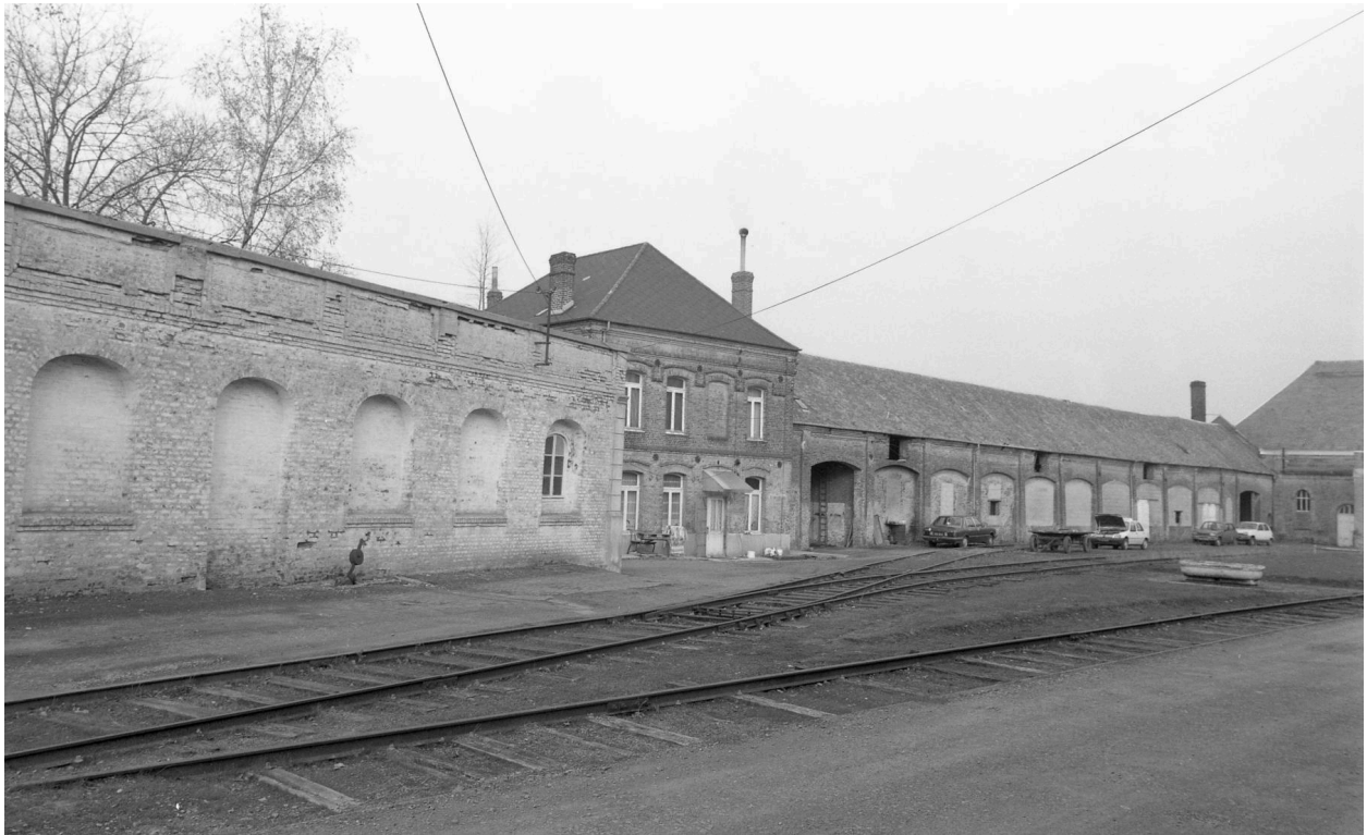
Façade sur cour des magasins à charbon et des voies ferrées qui traversent la cour pavée.
