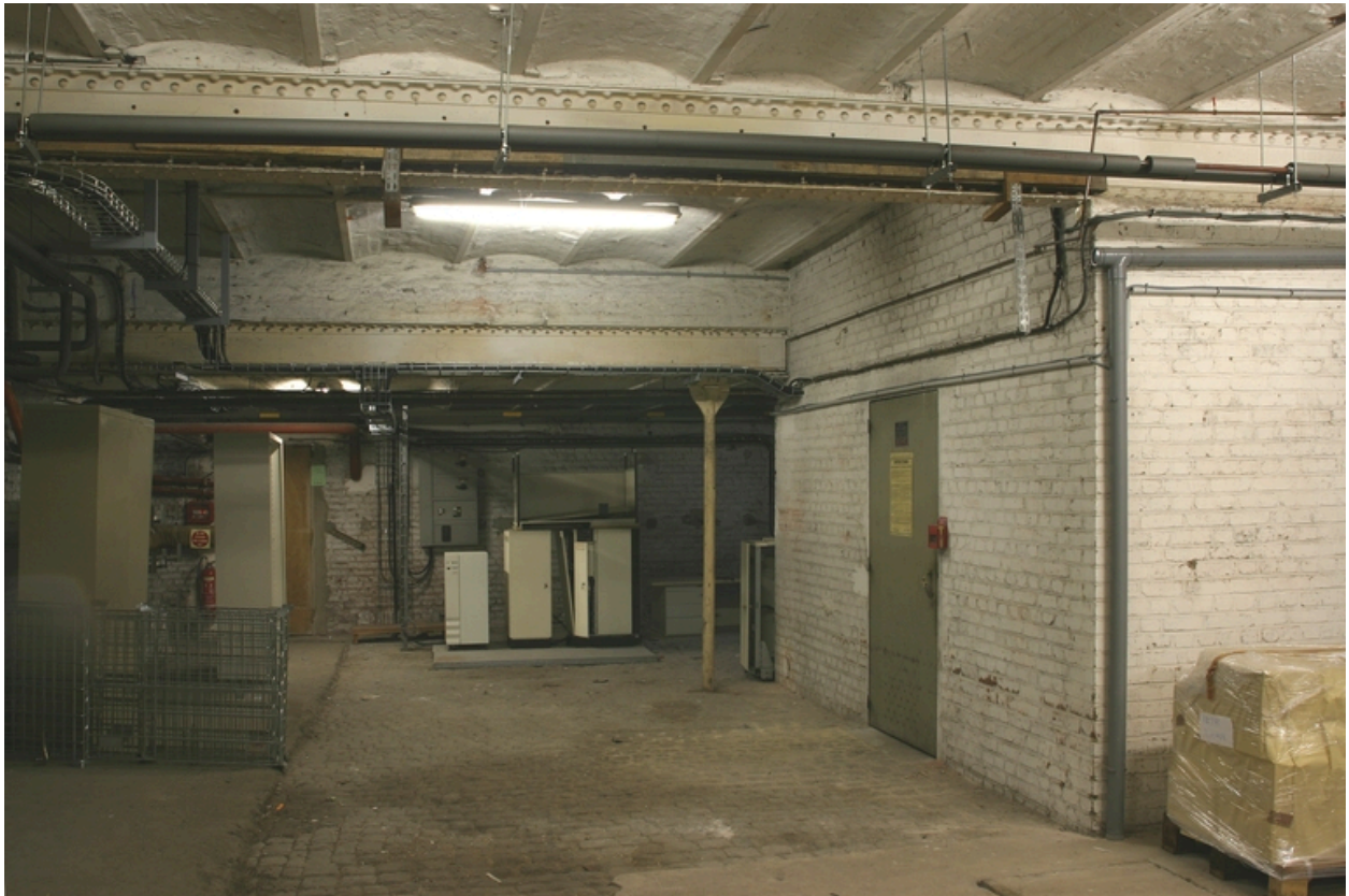
Sous-sol de la maison de commerce.
