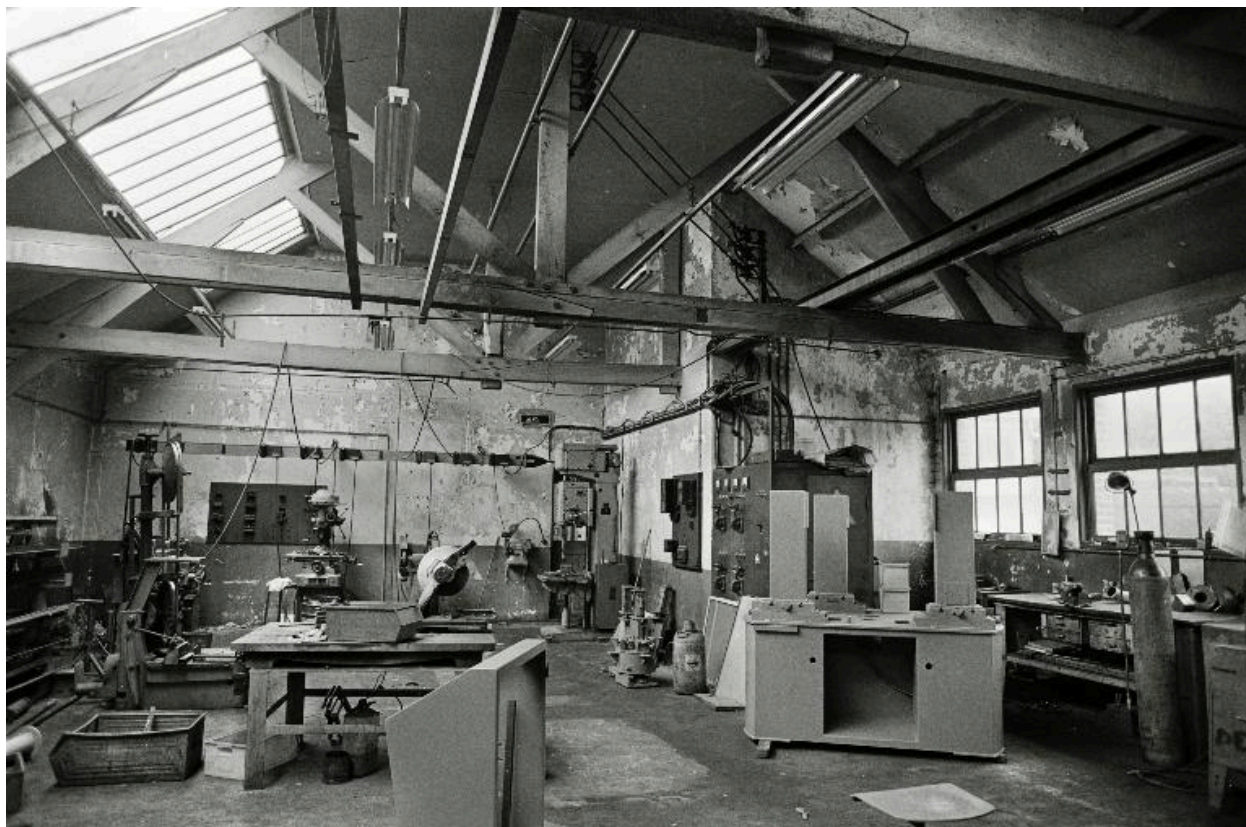
Atelier de fabrication (1946), vue intérieure en 1990.
