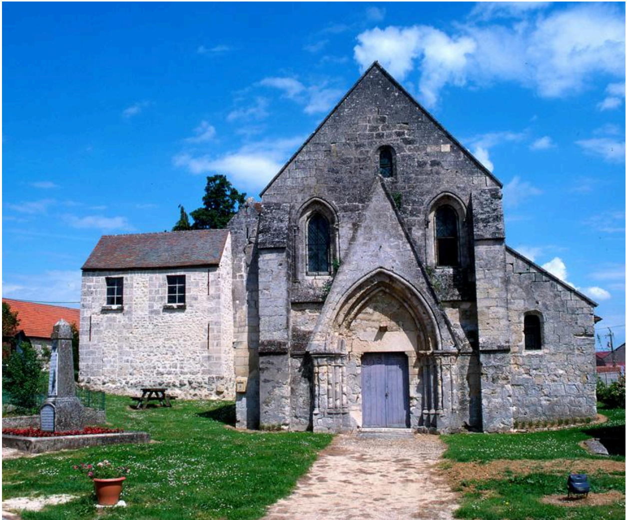
Vue extérieure de la façade occidentale.
