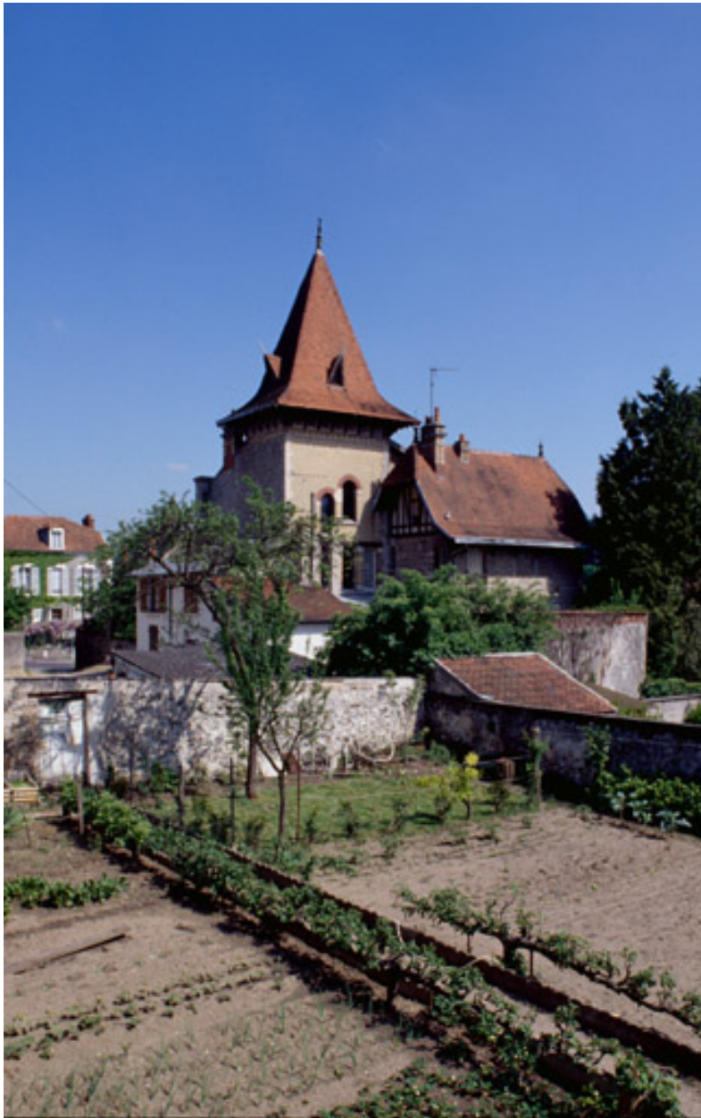
Vue d'ensemble nord-ouest.
