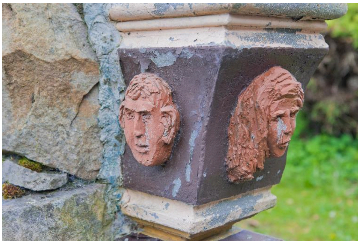
Détail de chapiteau.
