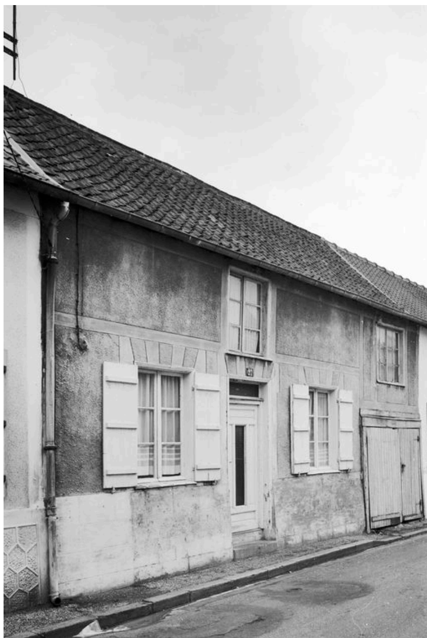
Elévation antérieure d'une maison de pêcheur.
