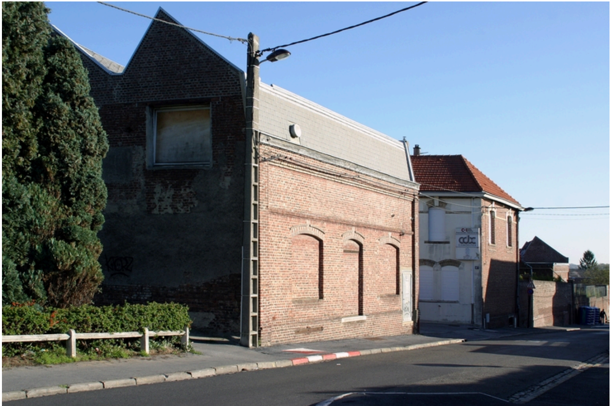
Entrée de l'usine.
