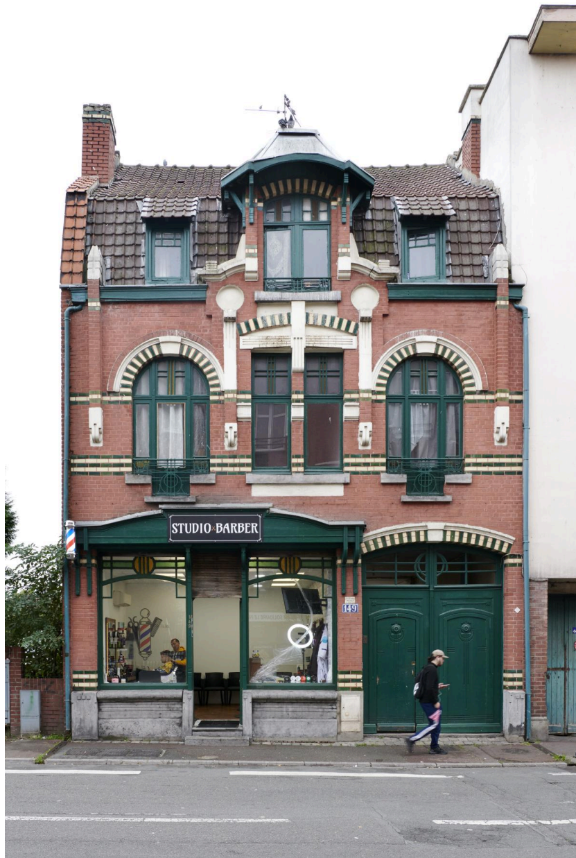
Façade de style Art nouveau, vue de face.
