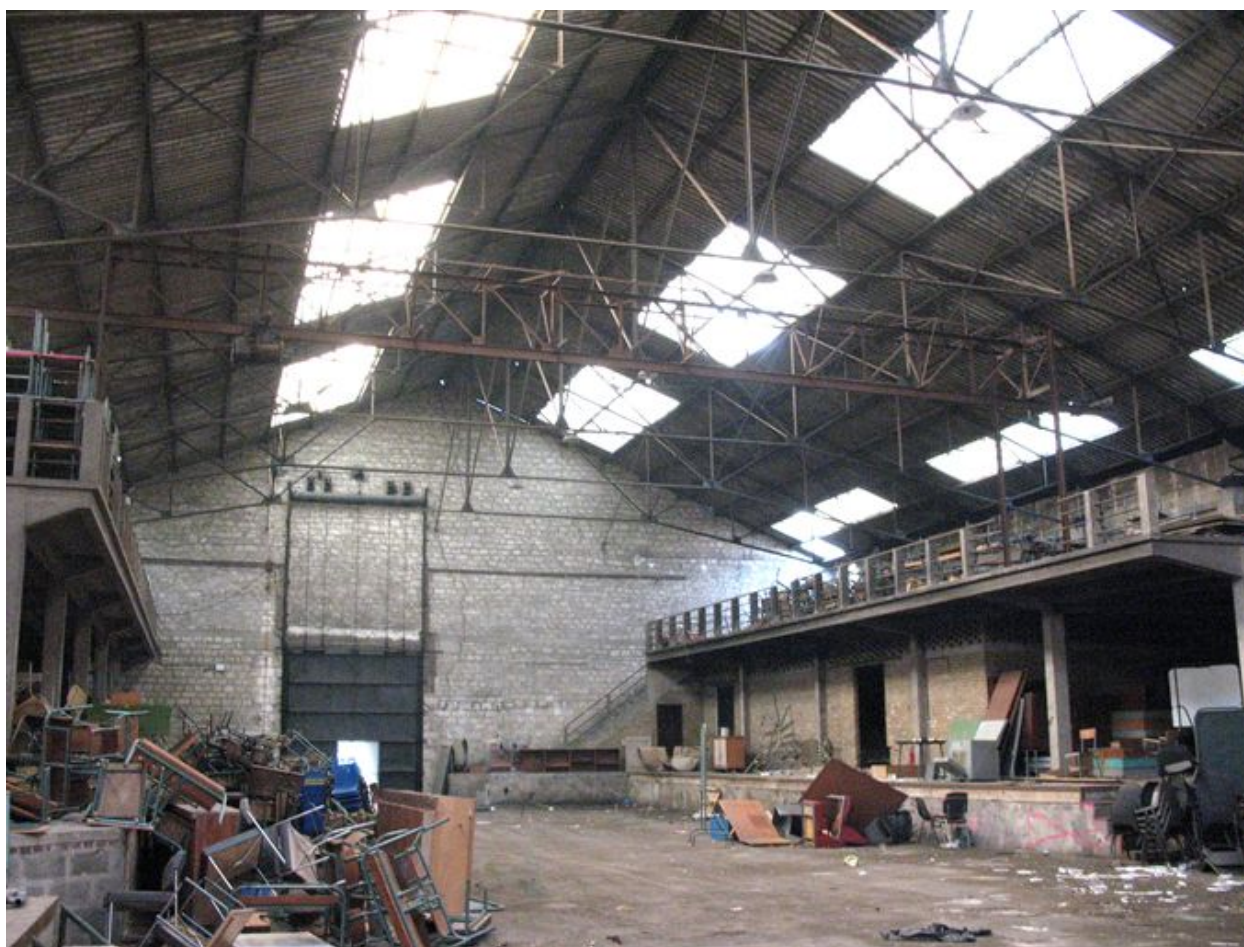
Vue intérieure de la halle principale.
