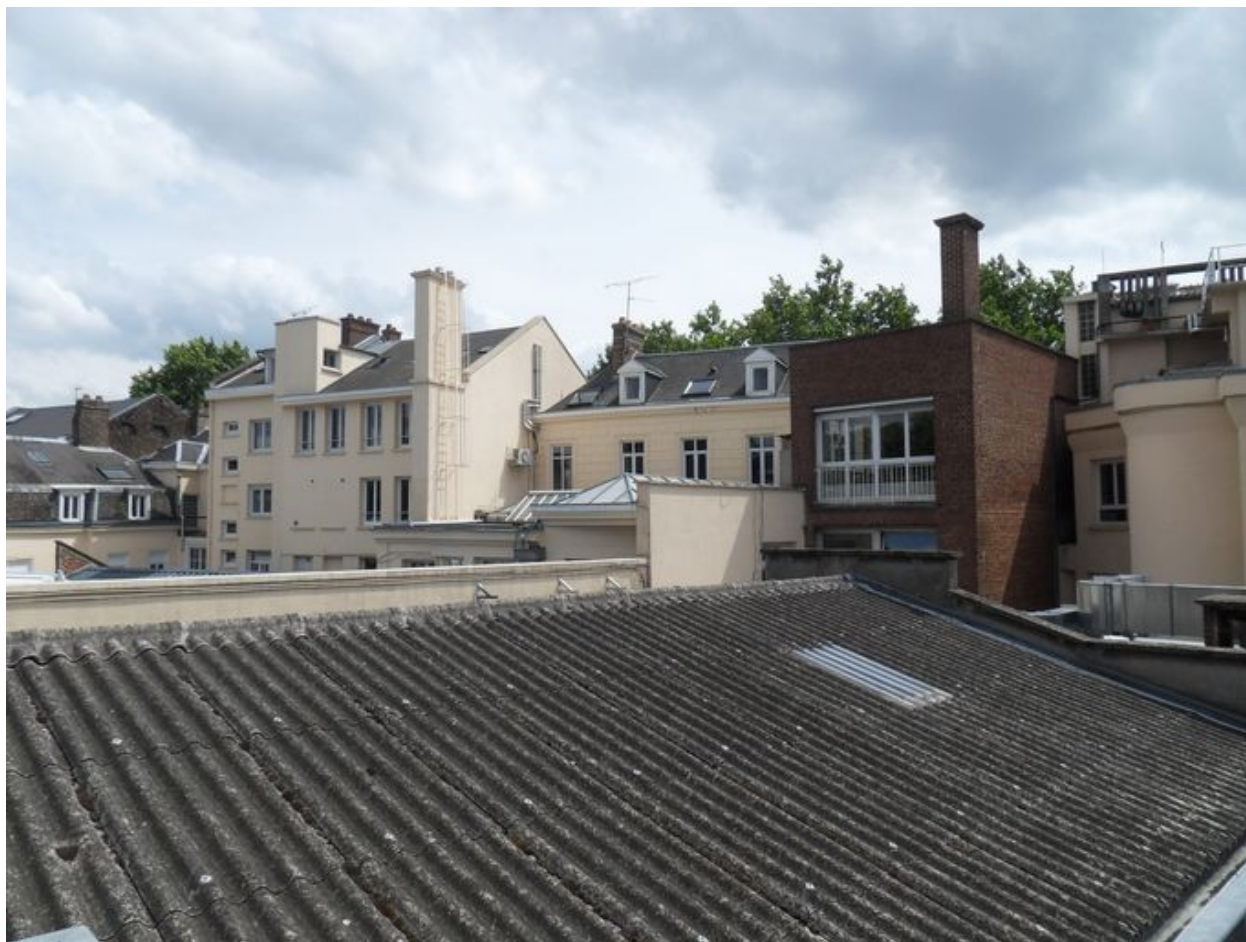
Façades arrières, depuis les salles des commissions.
