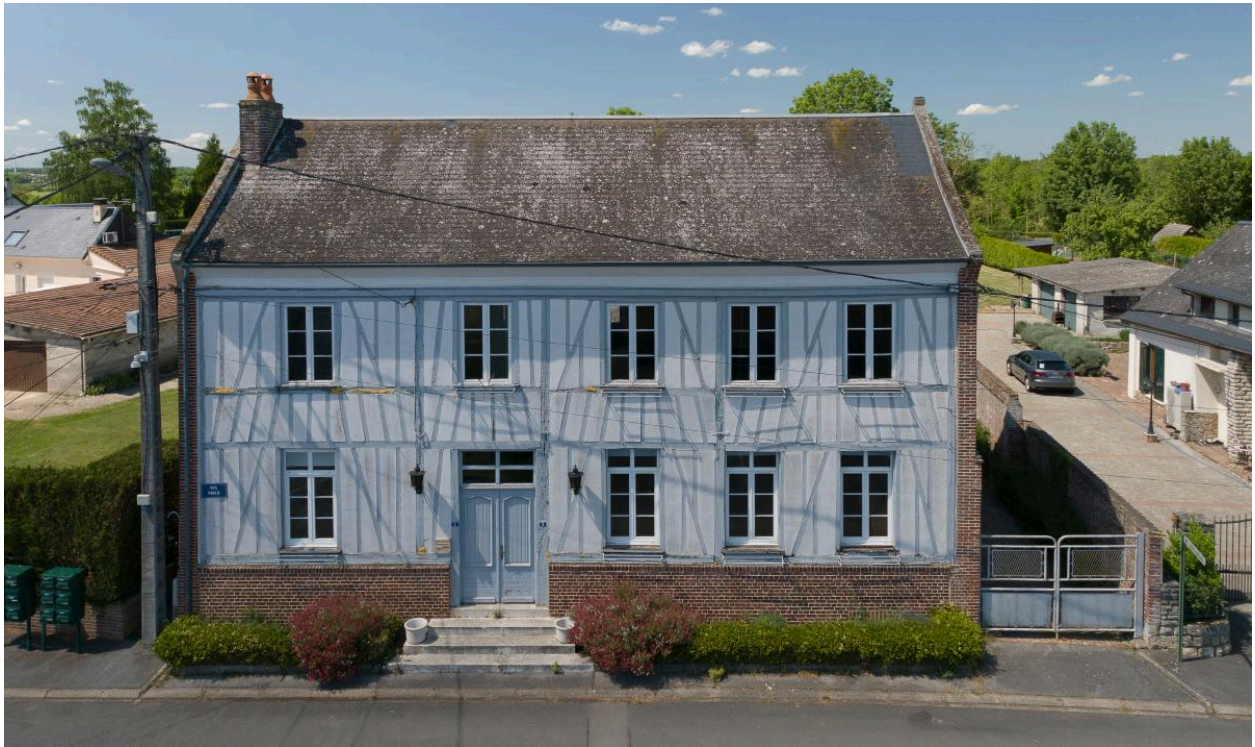
Ancienne mairie-école, n°1 rue Prien, vue depuis le sud-est.
