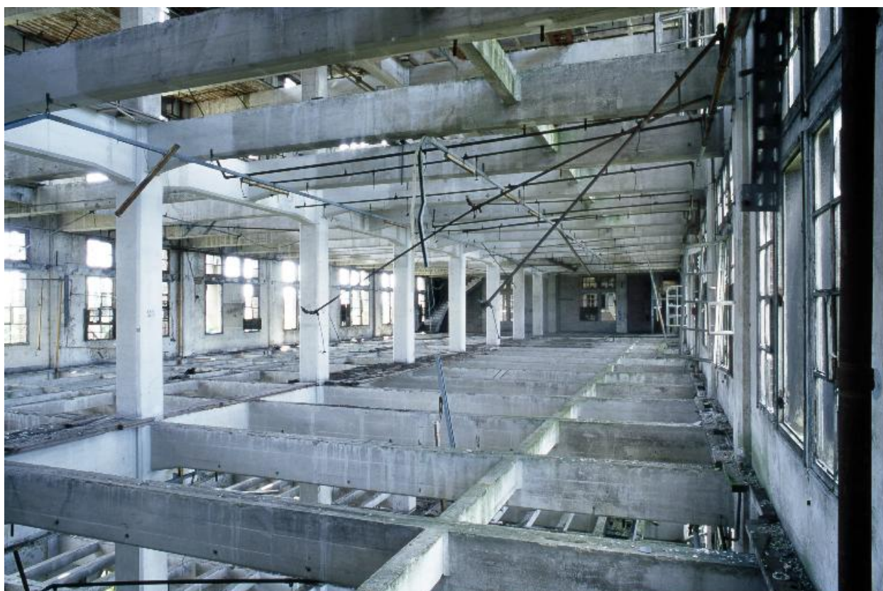
Bâtiment des moulins. Ossature en béton armé.
