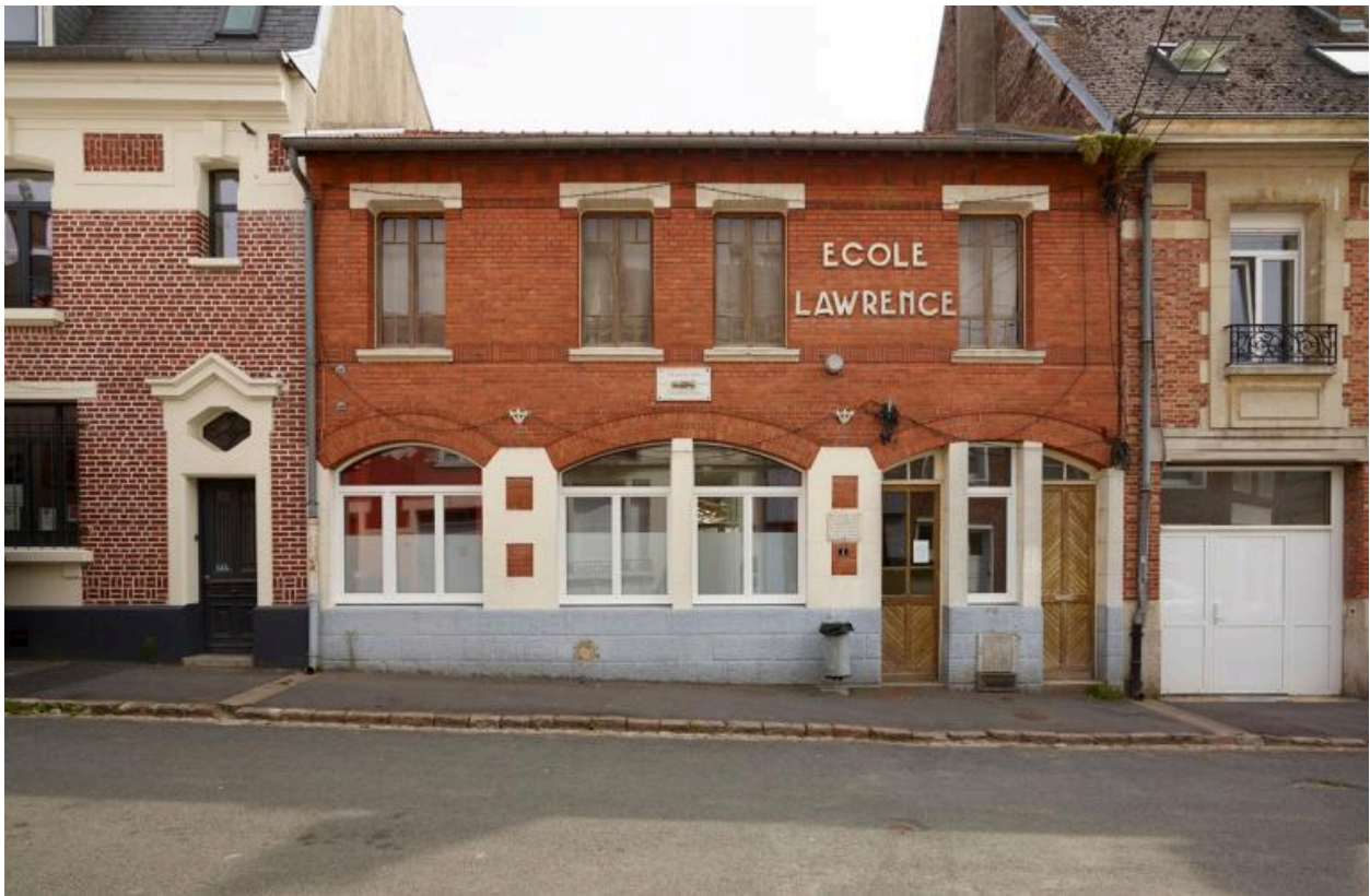
Ecole lawrence, rue Jean-Baptiste-Lequette. Construite en 1939.
