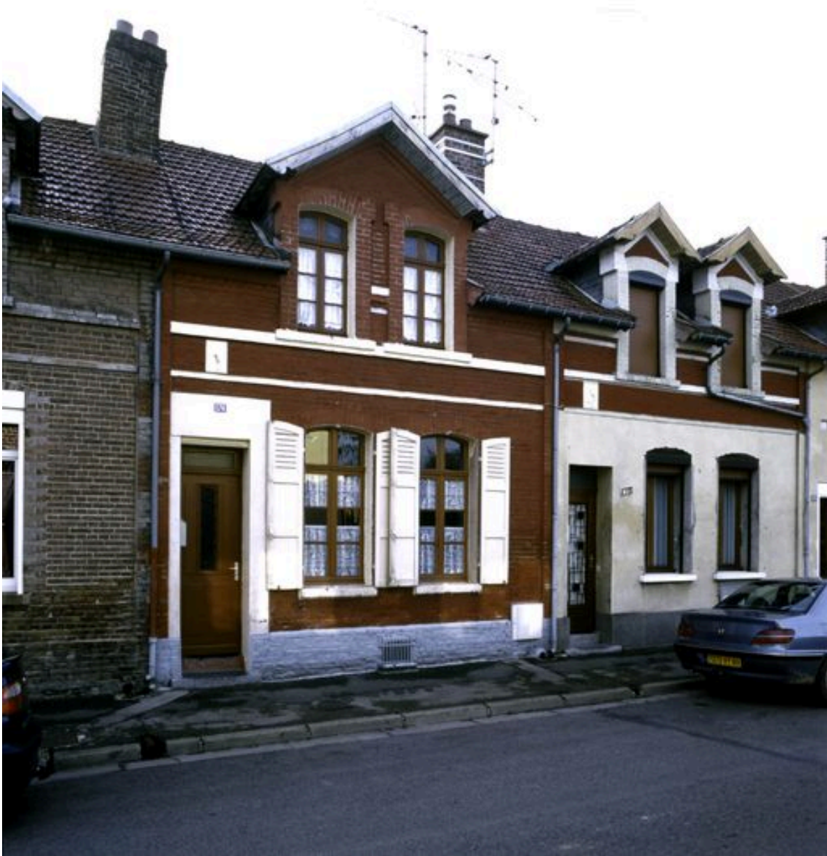
174 et 176 rue Jean-Catelas, maisons construites en 1922 et 1923.
