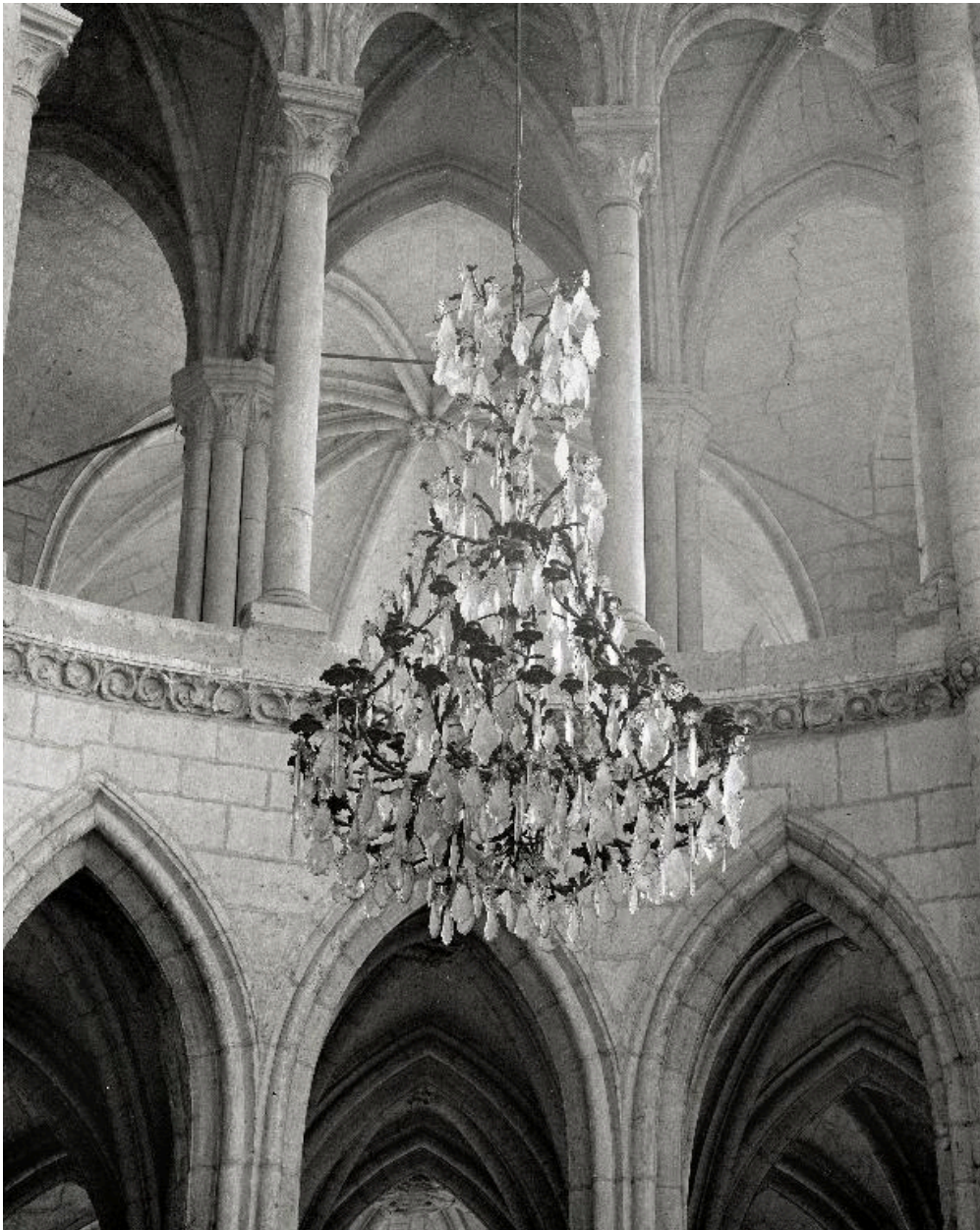
Bras sud du transept : vue générale du lustre.
