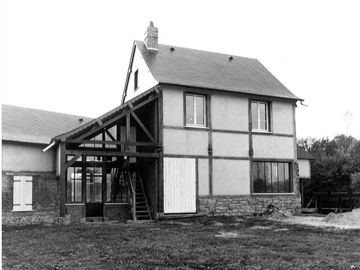
Façade ouest de l'atelier de fabrication.
