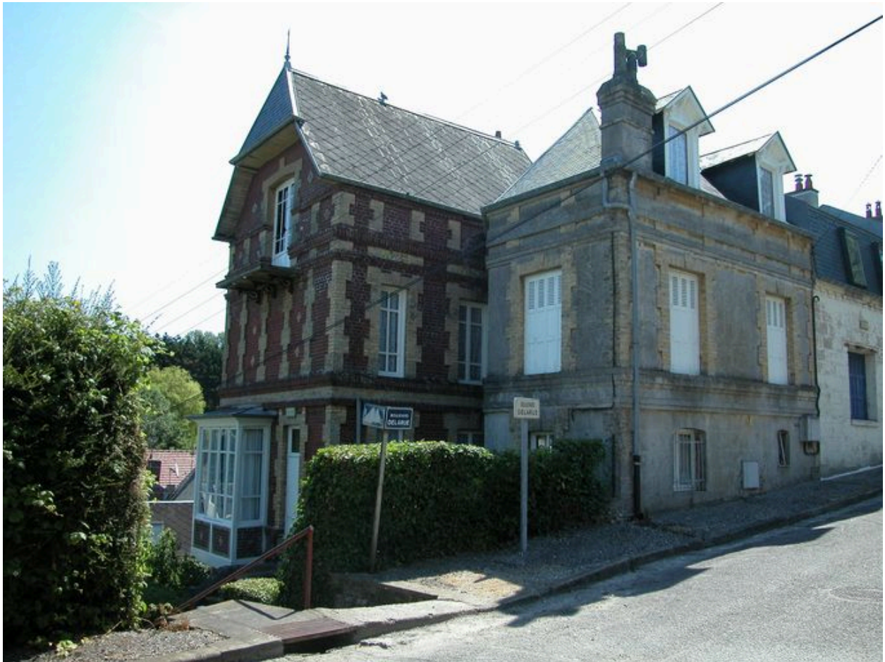
Vue d'ensemble depuis le boulevard Delarue.
