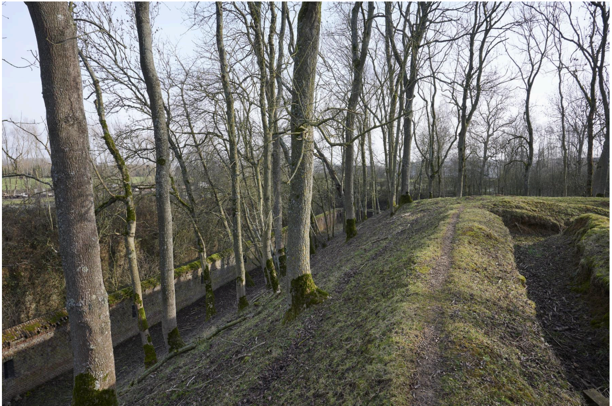
Fossé de gorge et contrescarpe depuis le chemin de ronde, vers l'est.
