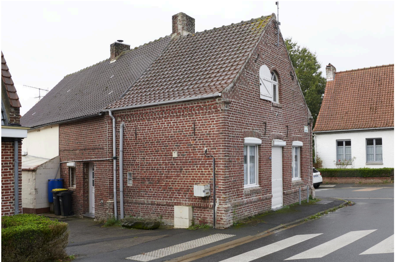
Vue depuis le nord-est.
