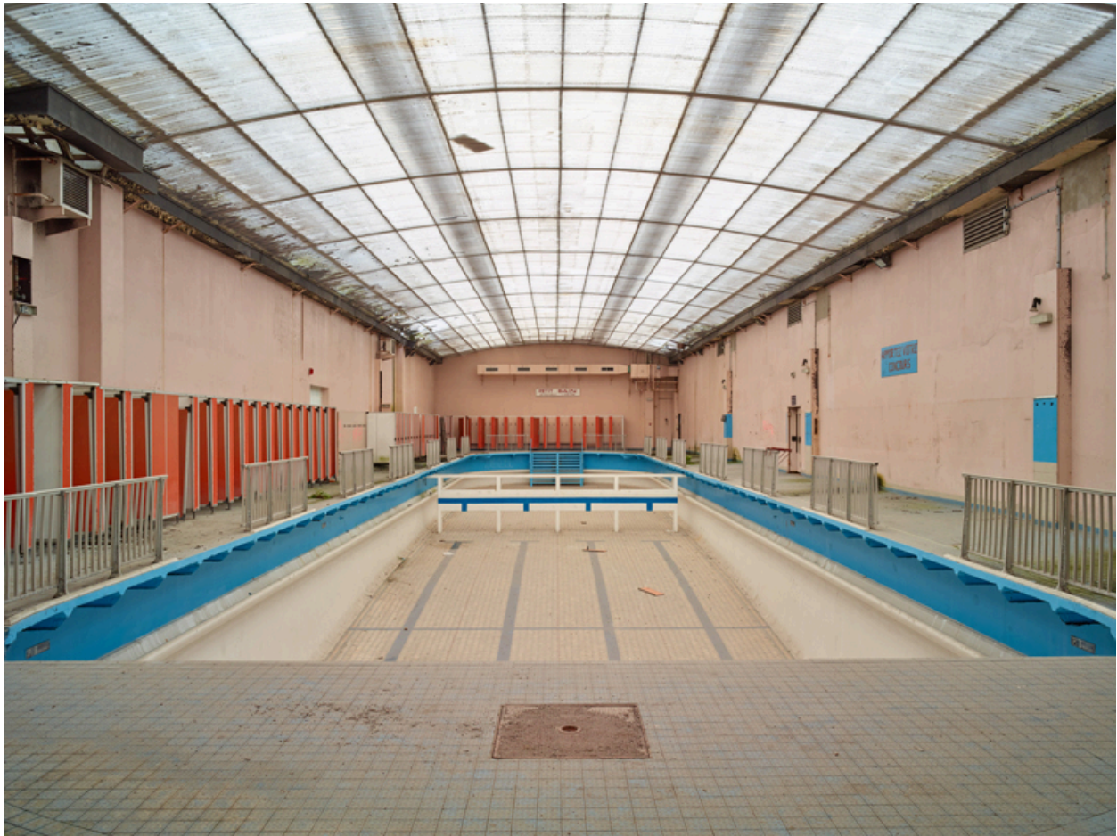
Vue générale axiale du bassin, vers le sud (petit bain).
