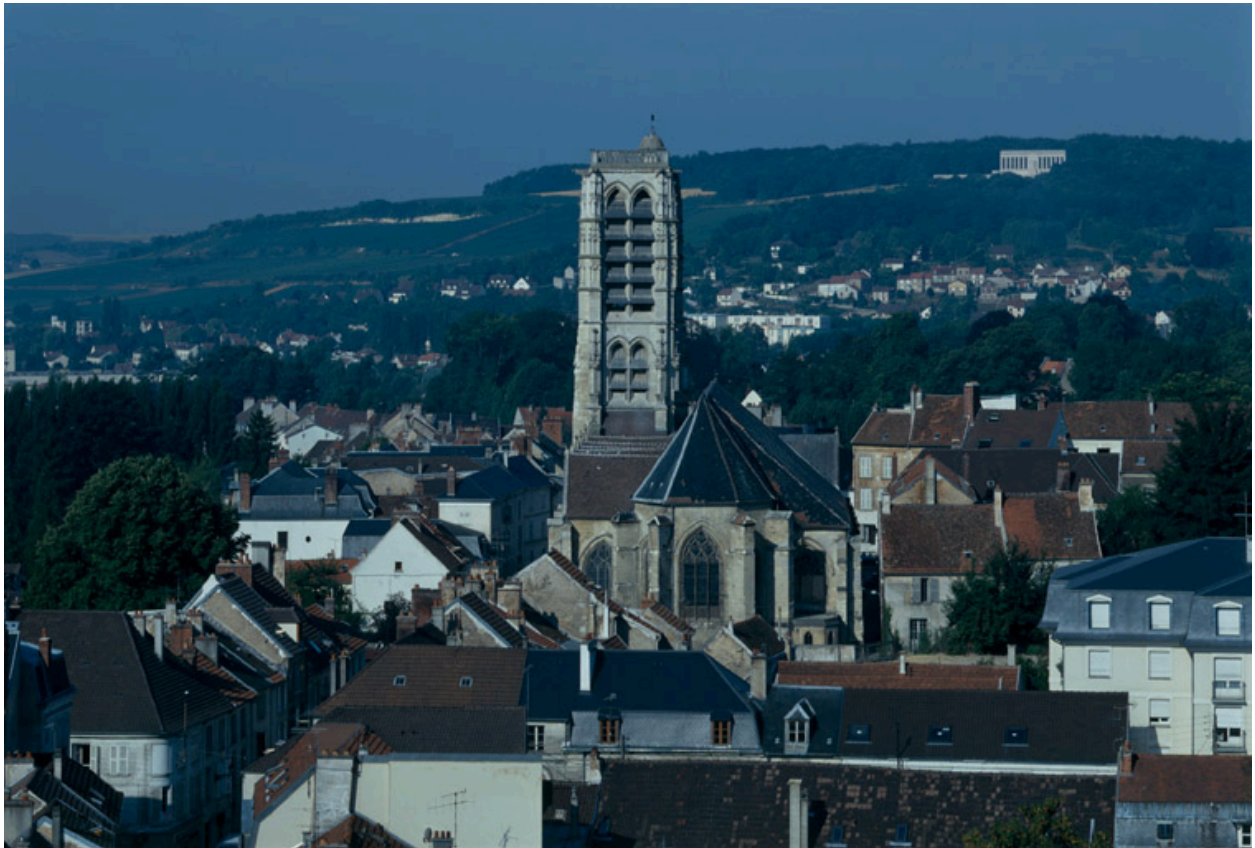
Vue générale du quartier de l'église Saint-Crépin avec le clocher ; vue depuis la plateforme du château.
