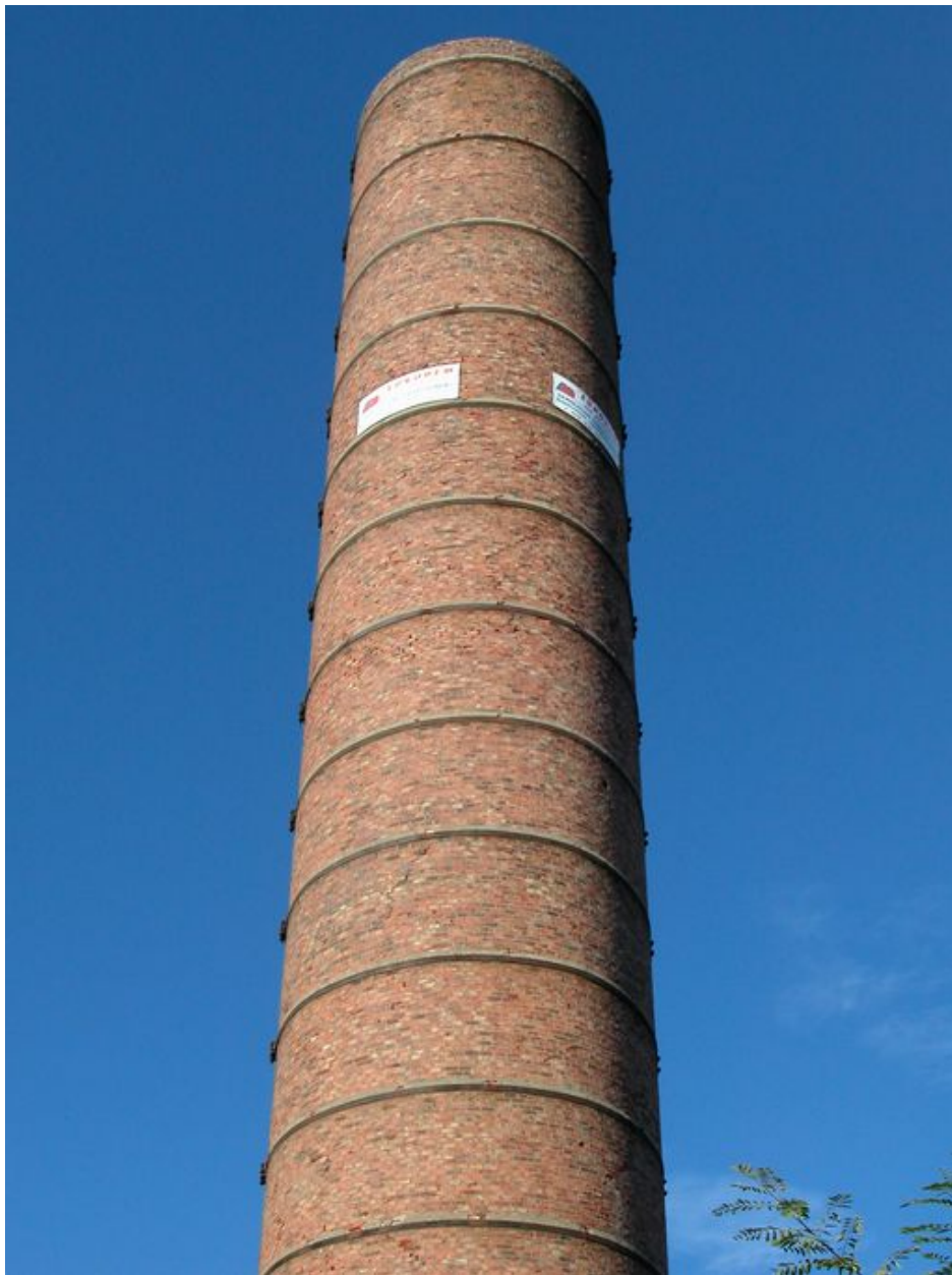
Le fut de la cheminée en brique.
