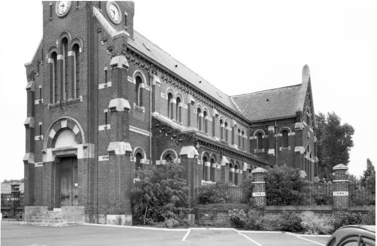
Vue latérale de la nef, vers le nord-est.
