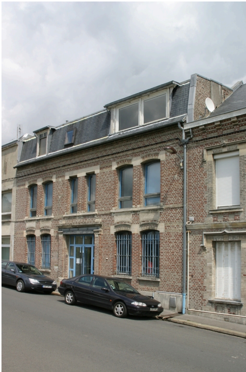
Entrée des bureaux et des ateliers de 1923, rue Voltaire.
