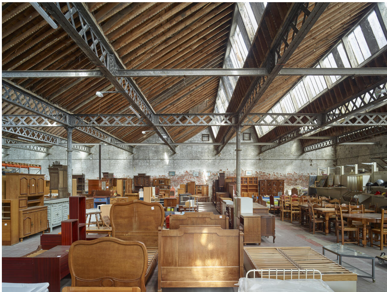
Vue intérieure des sheds de l'ancienne filature.
