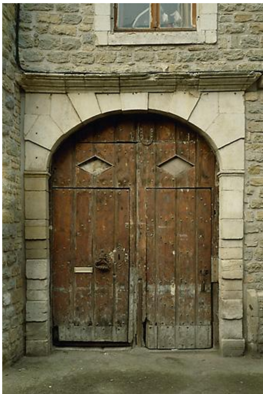
Façade sur voie, porte d'entrée : détail.
