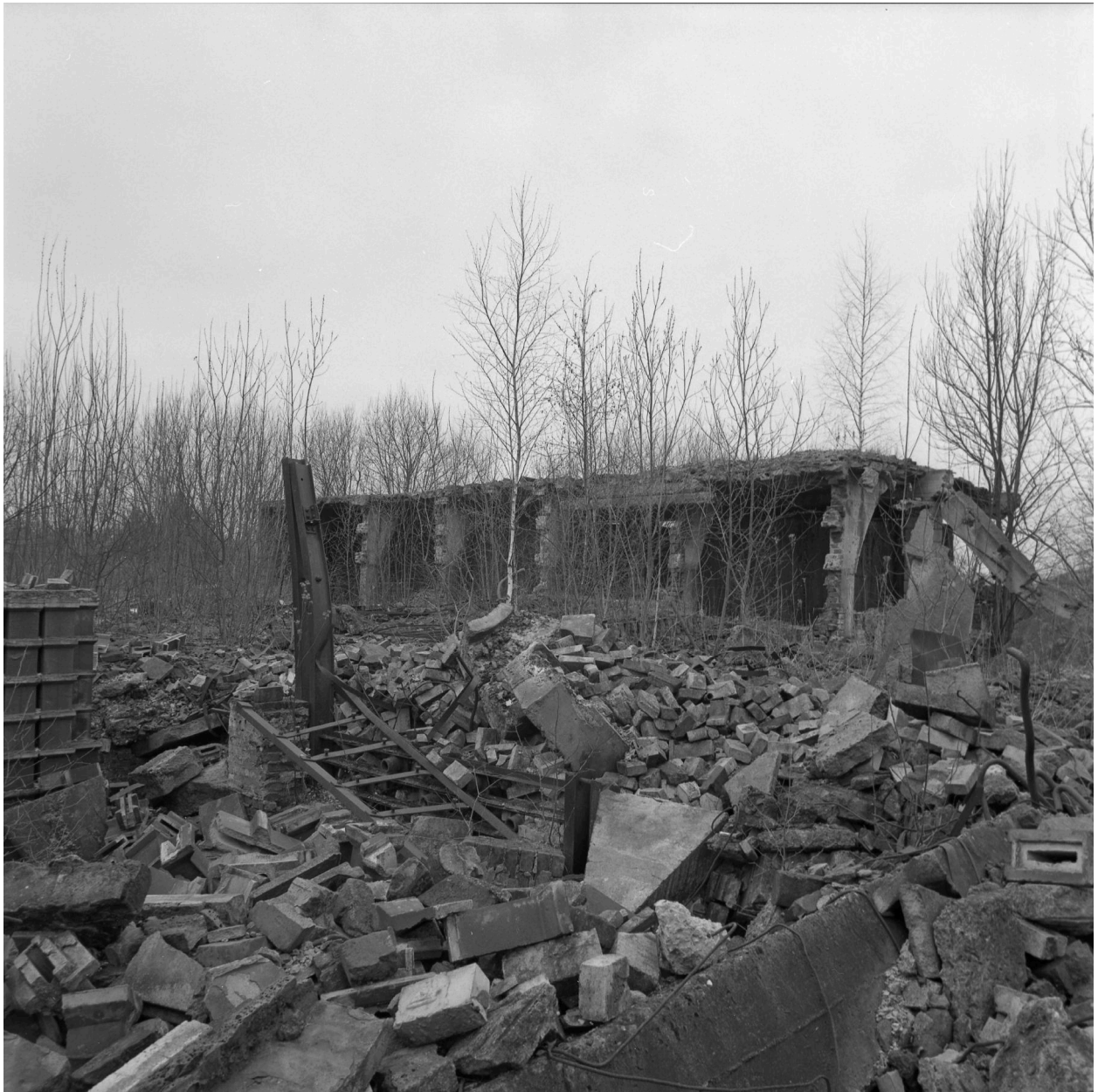
Vestiges du four de cuisson, état en 1996.
