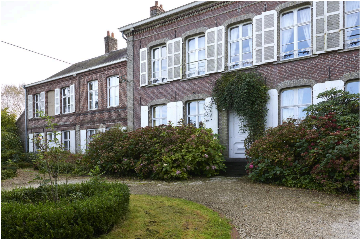
Les deux modules d'habitations depuis le nord-ouest.
