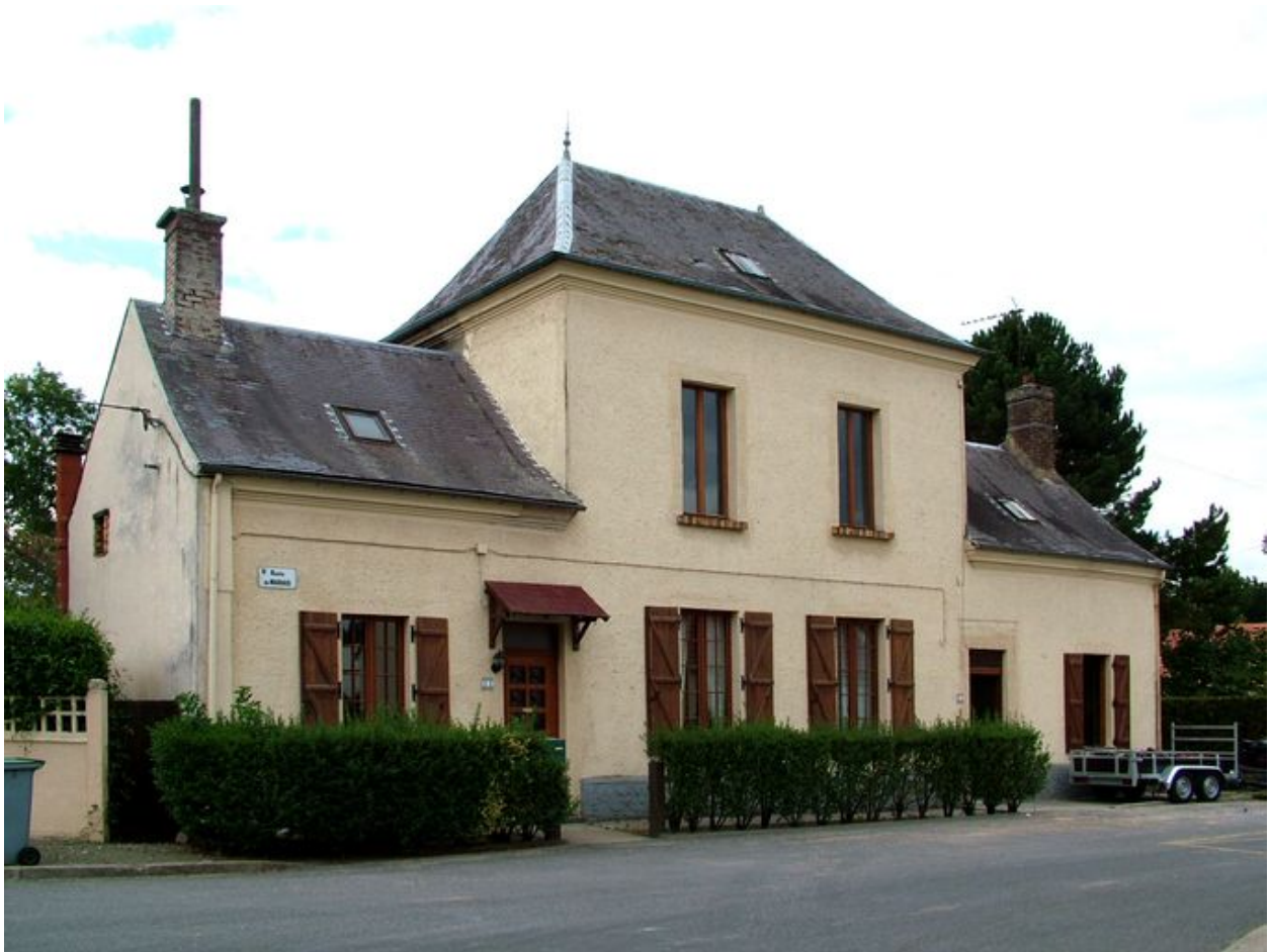
Pernois, ancien café de la Place, 11-21 rue du Marais, 4e quart du 19e siècle.
