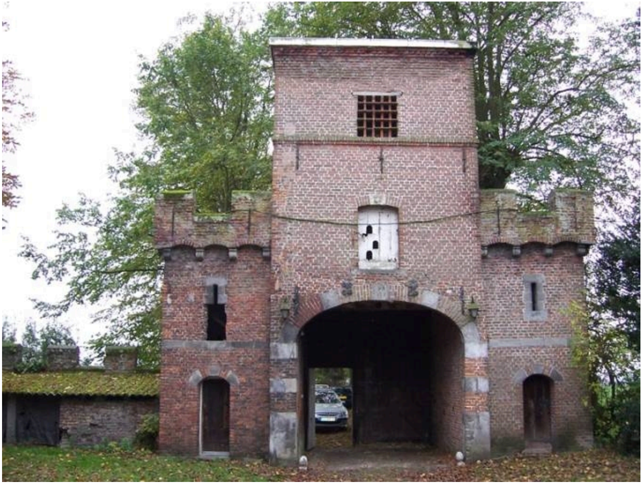
Vue générale du porche-colombier, élévation sur cour.
