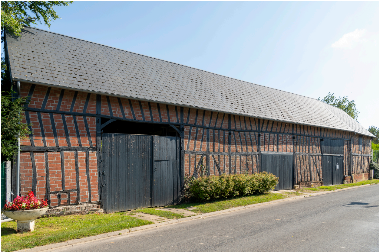
Grange, entrée charretière et bâtiments agricoles sur la rue, n°9 de la rue de la Folie, vue depuis l'ouest.
