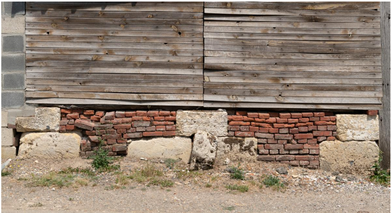
Mur en torchis et pans de bois essenté en bois sur solin en brique et pierre, n°10 rue d'En Haut.
