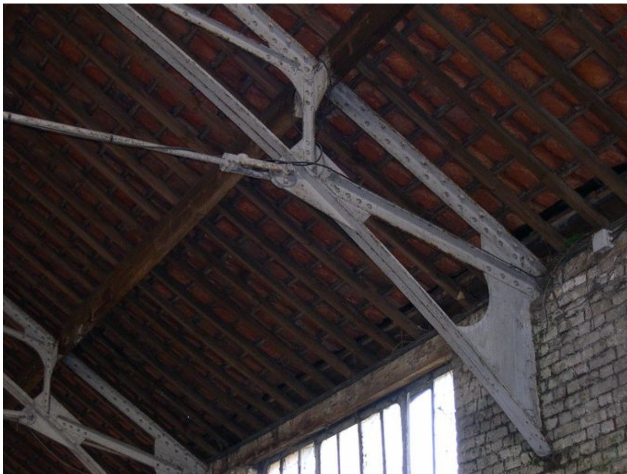
Intérieur : ferme métallique, détail.
