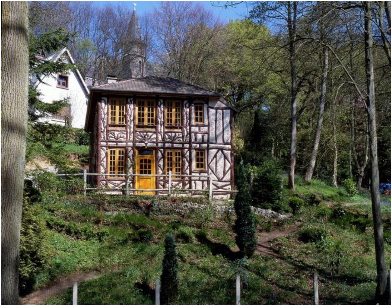
Vue d'ensemble après changement des huisseries.
