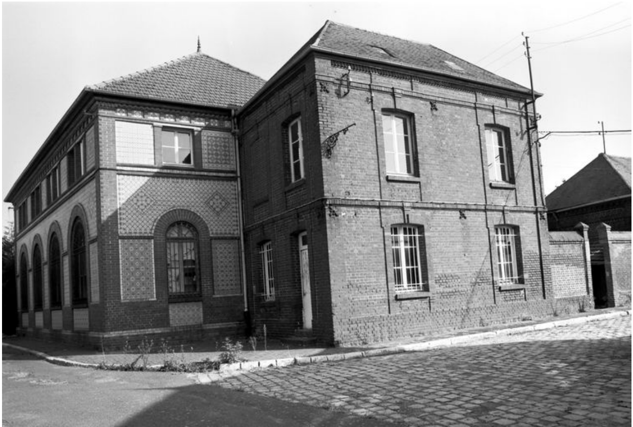
Mur sud du bureau.
