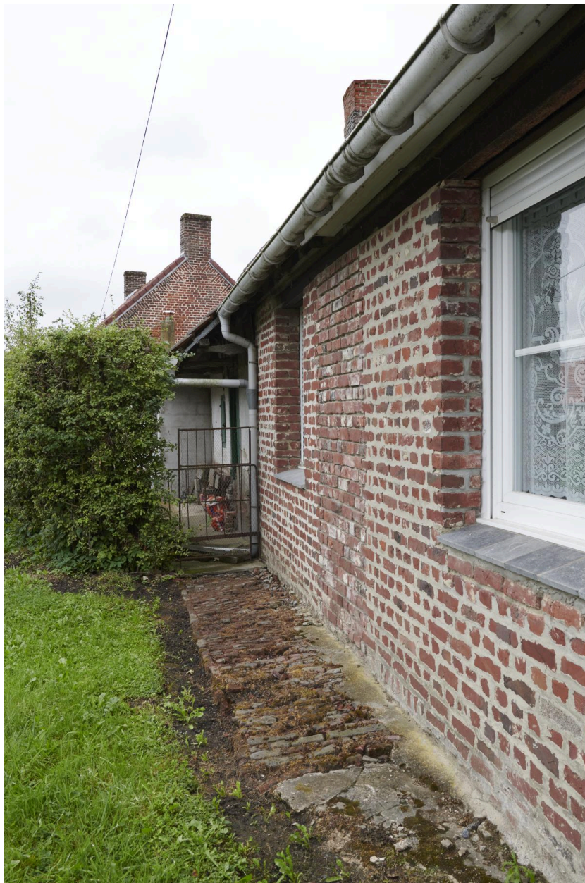
Détail du trottoir en brique situé le long du mur nord.
