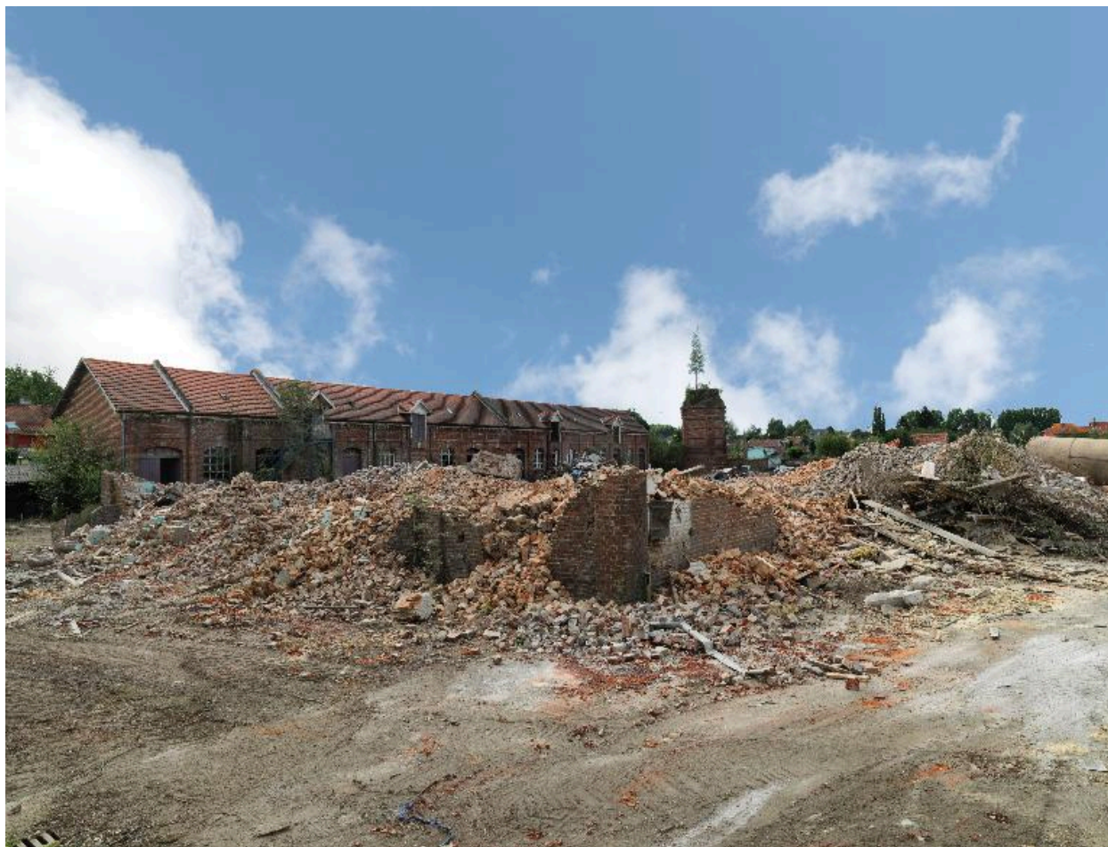
Vue d'ensemble des ateliers en cours de destruction, juillet 2012.
